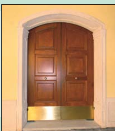
■ Fasce riportate con cornici in rilievo
